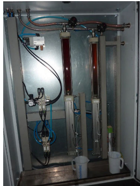
Рис.2: Шкаф дозирования с двумя насосами
